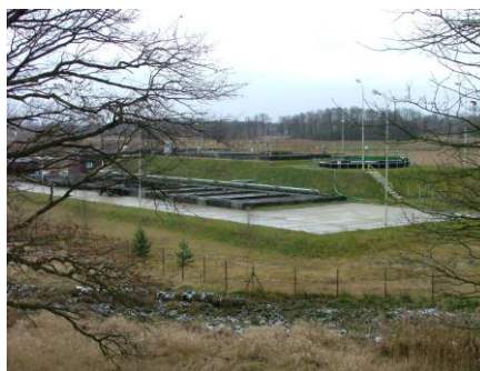
Rys. 20. Oczyszczalnie ścieków w Wiechlicach.
