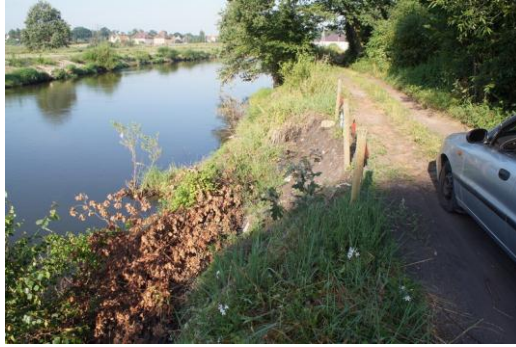
Rys 23. Wyrwa uszkadzająca drogę dojazdową do posesji przy ul. Sobieskiego.
