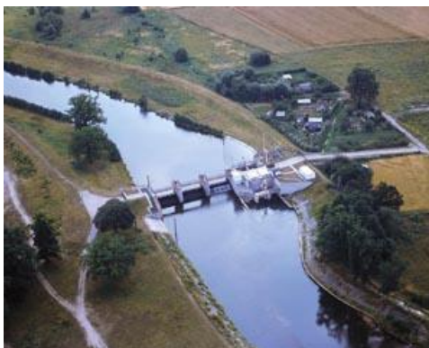
Rys. 21. Elektrownia wodna na rzece Bóbr w Szprotawie
